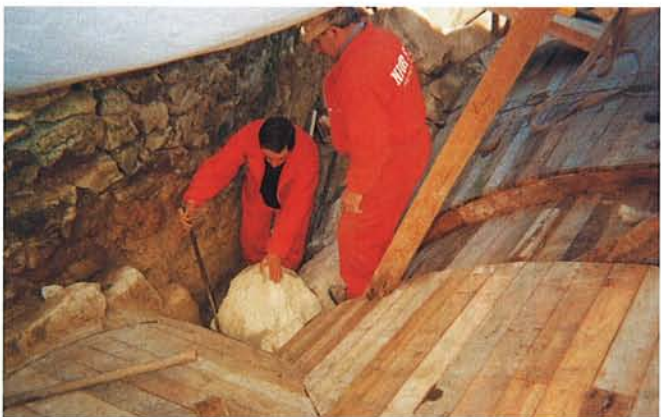
Figs. 21 y 22. Interior y exterior de la cimbra.
